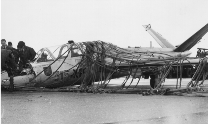
Le train avant du Fouga n°418 code 315-XP du Groupement École 00/315 n'a pas supporté l'arrêt.
