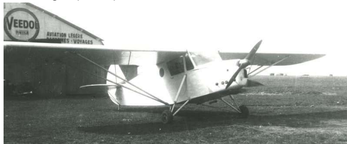
Le prototype du RA-14 alors équipé d'un moteur Train et encore non immatriculé (F-WBBP puis F-PBBP) (archives Espace Air Passion)
