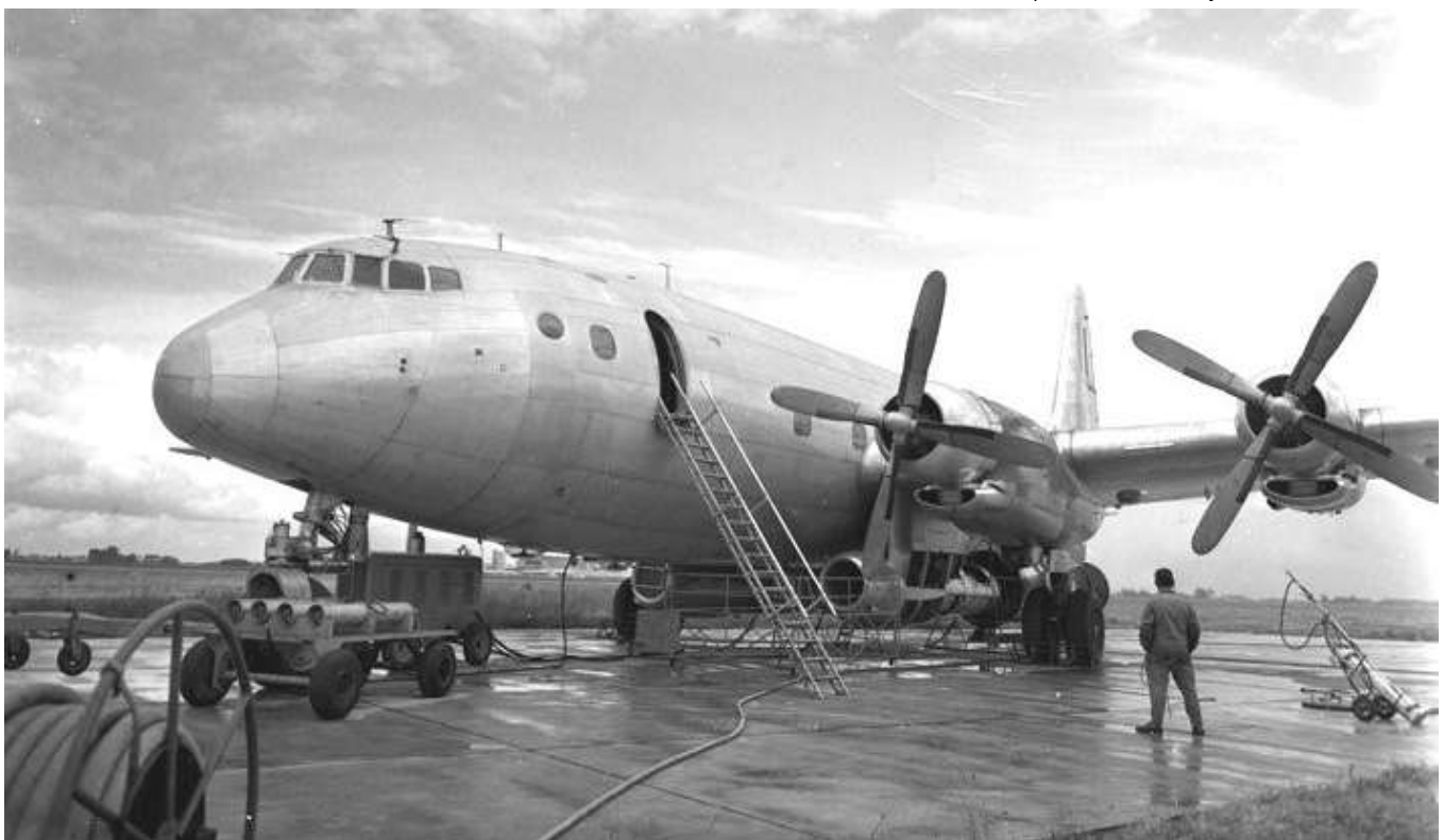
Le SNCASE SE.2010 « Armagnac » avec les deux nacelles sous l'emplanture des ailes Photo © Espace Patrimoine Safran
